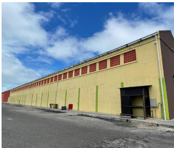
Fachada lateral do Armazém 04
