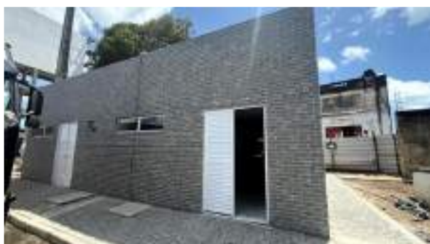
Figura 10 – Central de Resíduos
