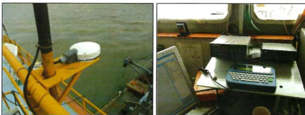
Figura 17: Sistema de Rastreamento DGPS instalado na draga (Fonte: Acervo Próprio)
