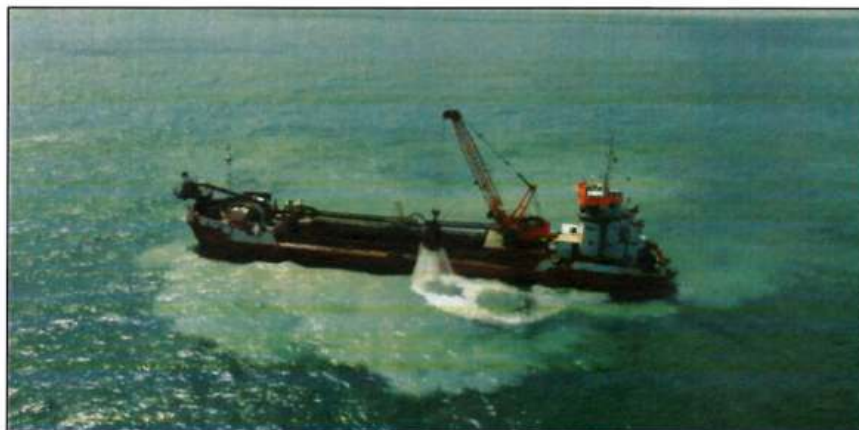
Figura 13: Operação da Draga Multipropósito com Orange Peel Hidráulico (Fonte: Acervo Próprio)
