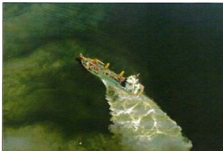
Figura 16: Exemplo de Operação de Descarte de Material de Dragagem em Bota-Fora Oceânico (Fonte: Acervo Próprio)
